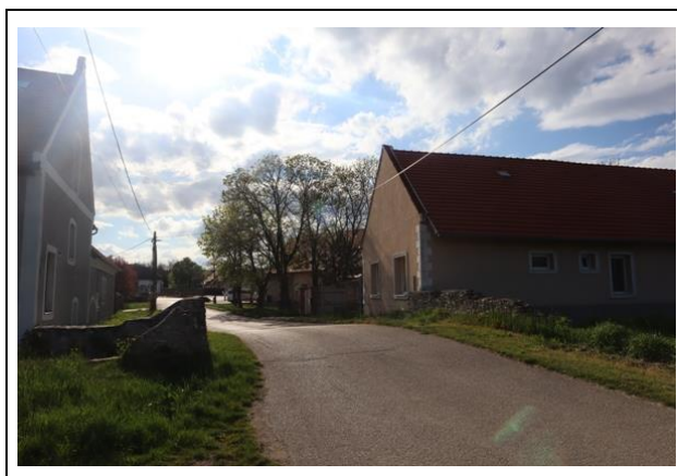
környezet, a Vasút utca látképe
